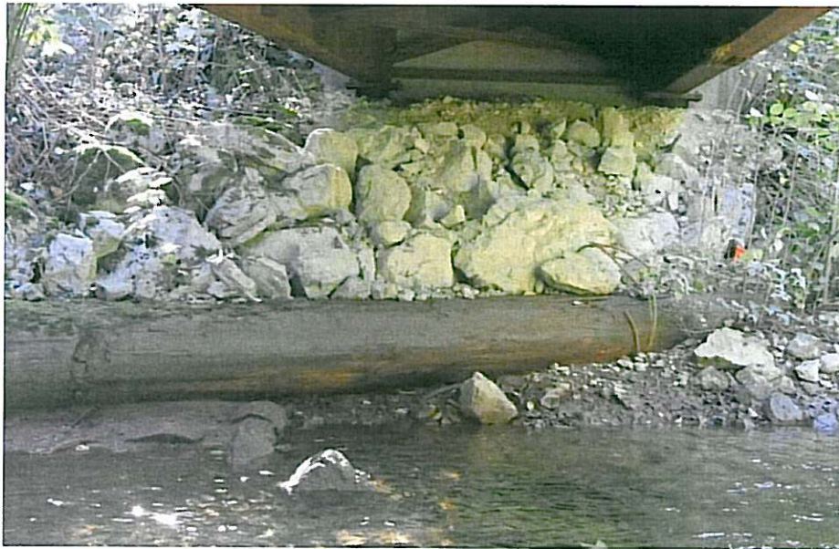
CK-2218 left riprap
